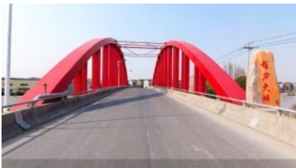
筹建顿力大桥
